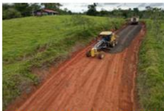
Reacondicionamiento de la subrasante Camino La Tigra Abajo
