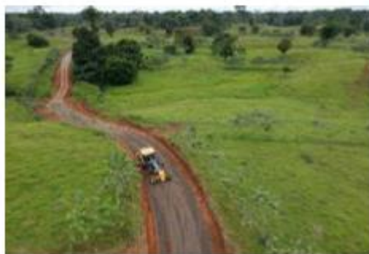
Reacondicionamiento de la subrasante Camino La Tigra Abajo
