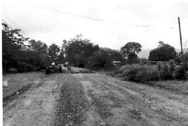
Ejecución: Colocación material de lastre.
