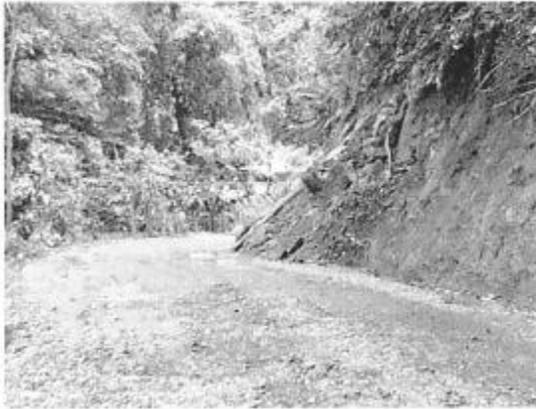
Derrumbe en la cuneta durante inspección.
