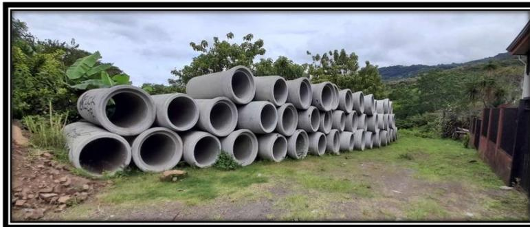
Ilustración 2: Alcantarillas de 90 cm, apilamiento incorrecto
