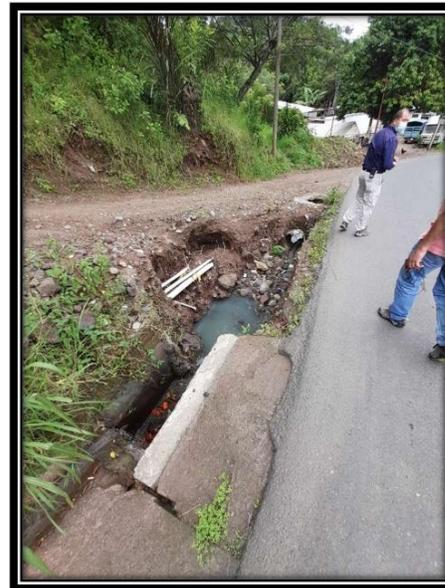
*Ilustración 2: Pozos tragantes por construirse en alcantarillado de 90 cm*
