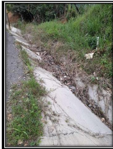
*Ilustración 2: Presencia de sedimentos y basura en las cunetas construidas - Sector Colegio Salitrillos*
