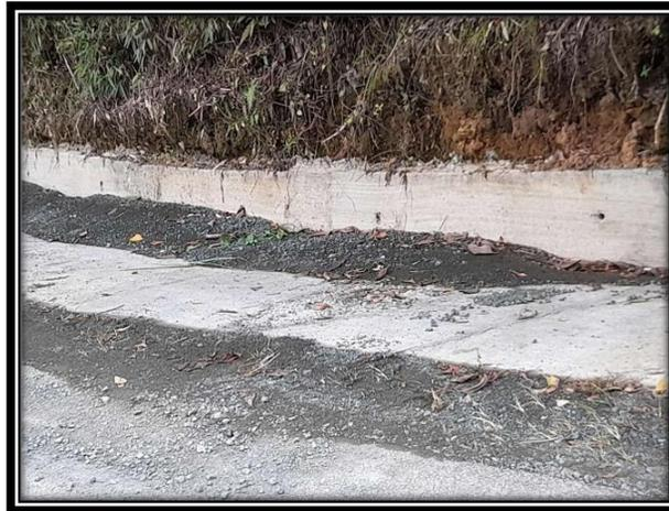
Ilustración 4: Presencia de sedimentos en las cunetas construidas
