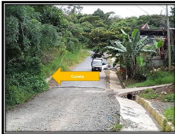
Ilustración 3: Limpieza de cunetas requerido - asfaltado no se finalizó hasta la cuneta
