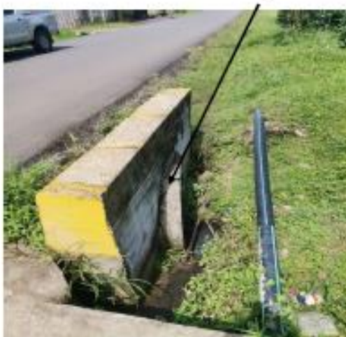
Ilustración N° 3 alineamiento entre el cabezal y la alcantarilla.
