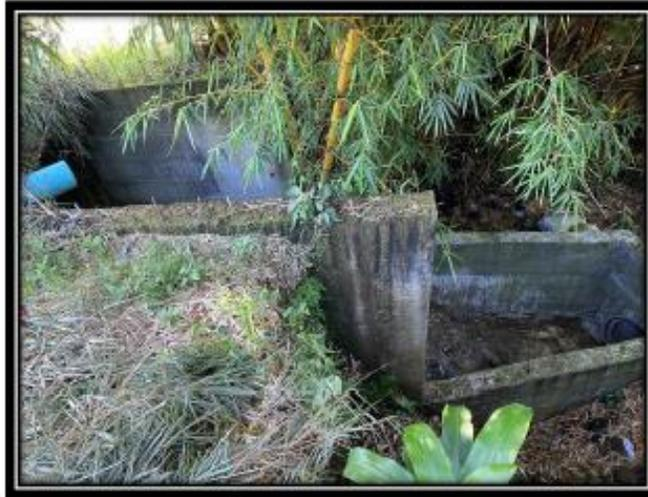
*Ilustración 3: Cuneta y caja de drenaje*
