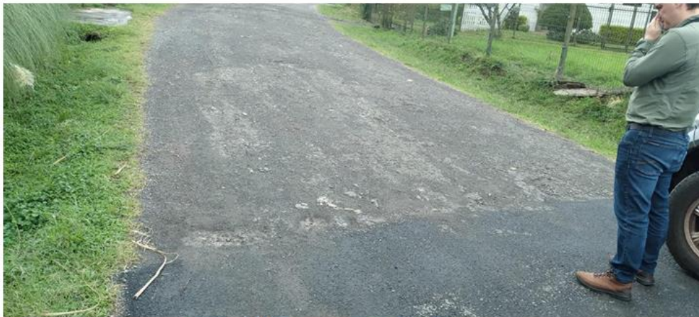
Ilustración 3 Acumulación de maleza en cunetas
