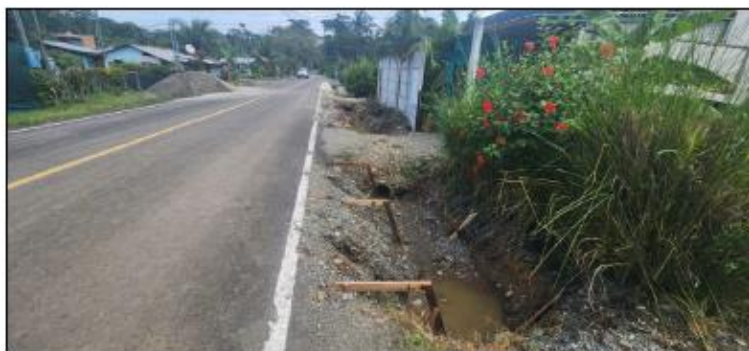
Figura 1. Construcción de cunetas tipo canal en frente de Patiño Fuente: FEPI-CORBANA, 2024.
