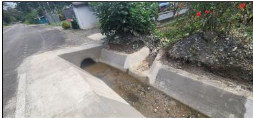
Figura 3. Cabezal de alcantarilla y vertedor hacia cunetas tipo canal en Patiño Fuente: FEPI-CORBANA, 2024.
