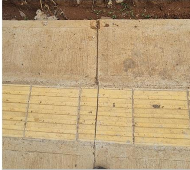
Ilustración 3 Juntas de construcción y corte de loseta.
