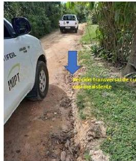
Cunetas en tierra con sección transversal que no cumple con la norma
