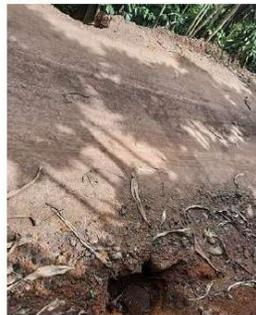
Paso de alcantarilla dañado que requiere cambio
