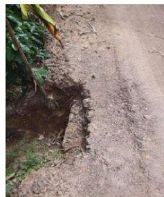
Paso de alcantarilla dañado que requiere cambio y construcción de cabezales
