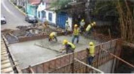
Concreto estructural de alcantarilla T c
