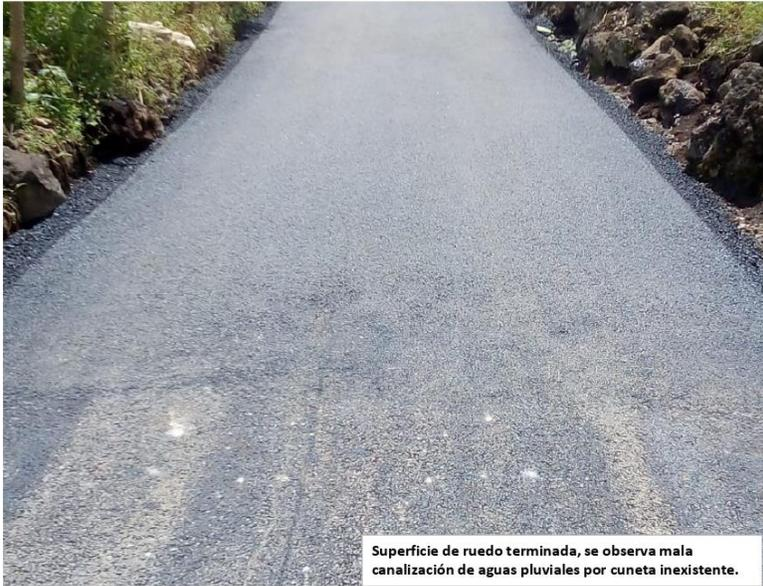
Superficie de ruedo terminada, se observa mala canalización de aguas pluviales por cuneta inexistente.
