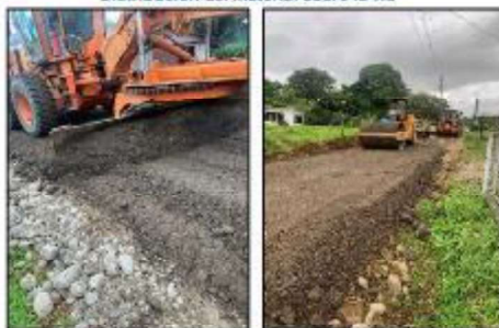
Distribución y compactación del material sobre la vía
