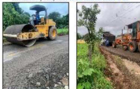
Compactación del material
