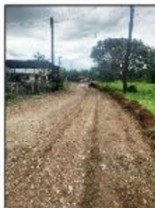
Conformación de cunetas
