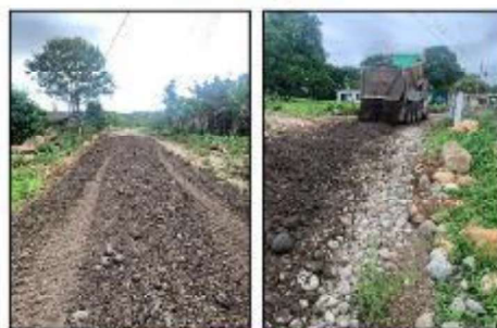
Suministro de material para lastrado
