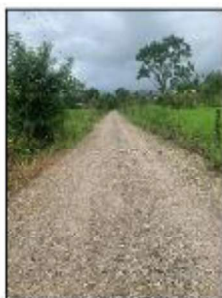
Derecho de vía
