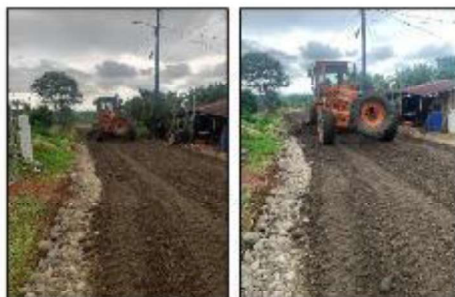
Distribución del material sobre la vía
