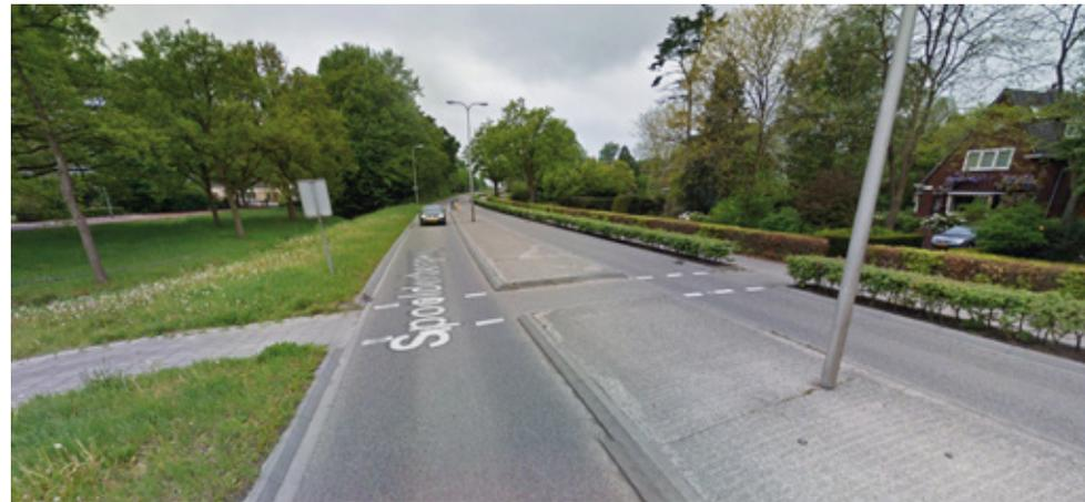
Figura 2.3. Un cruce peatonal sobre una vía distribuidora con prioridad para personas conductoras en las afueras de Zwolle, Países Bajos. La longitud de la recta en ambas direcciones permite anticipar los vehículos, y la isla de refugio permite cruzar un sentido de circulación a la vez. Un solo carril angosto por sentido para personas conductoras obliga a moderar la velocidad y hace más corto y seguro el cruce a pie.
