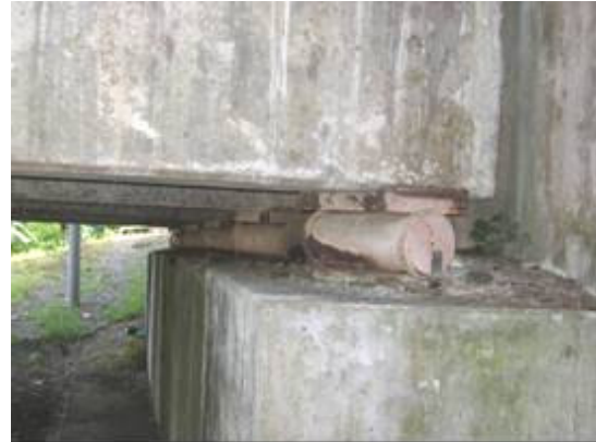
Figura 1.25 Apoyo expansivo tipo rodillo
