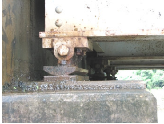
Figura 1.24 Apoyo expansivo tipo patín
