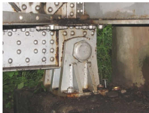
Figura 1.27 Apoyo fijo de acero
