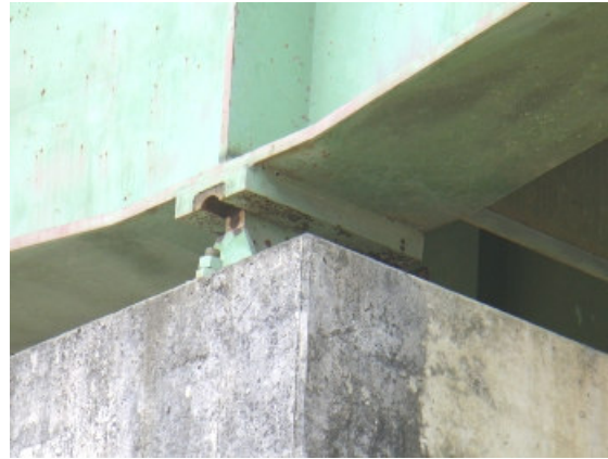
Figura 6-37 Movimiento del apoyo (grado 5)
