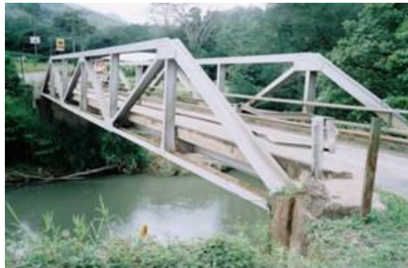
Figura 1.18 Puente tipo pony
