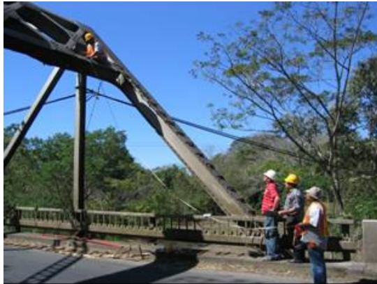
Figura 2-8 Actividades de inspección en alturas
