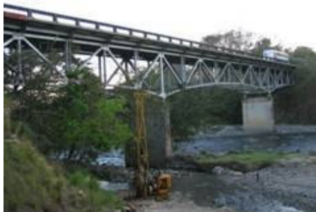
Figura 1.16 Cercha paso superior
