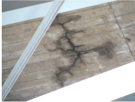
Figura 6-15 Grietas en dos direcciones
