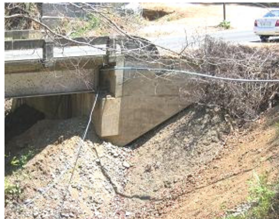
Figura 6-38 Relleno de aproximación
