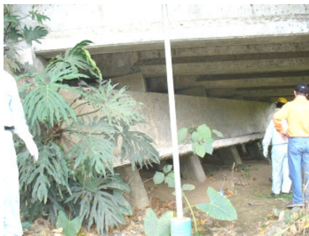
Figura 6-40 Inclinación del bastión por sismo (grado 5).
