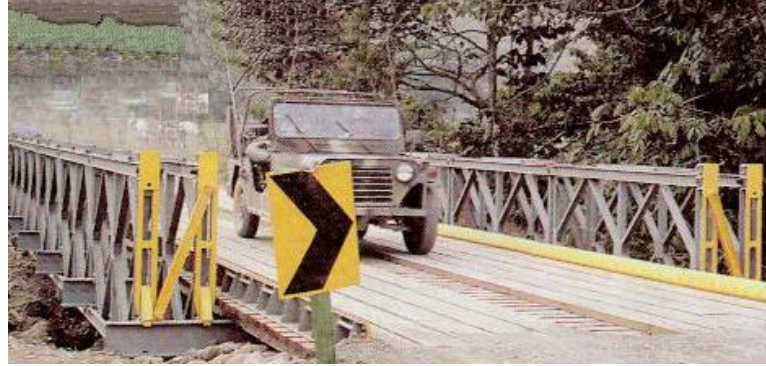
Figura 1.17 Puente tipo bailey
