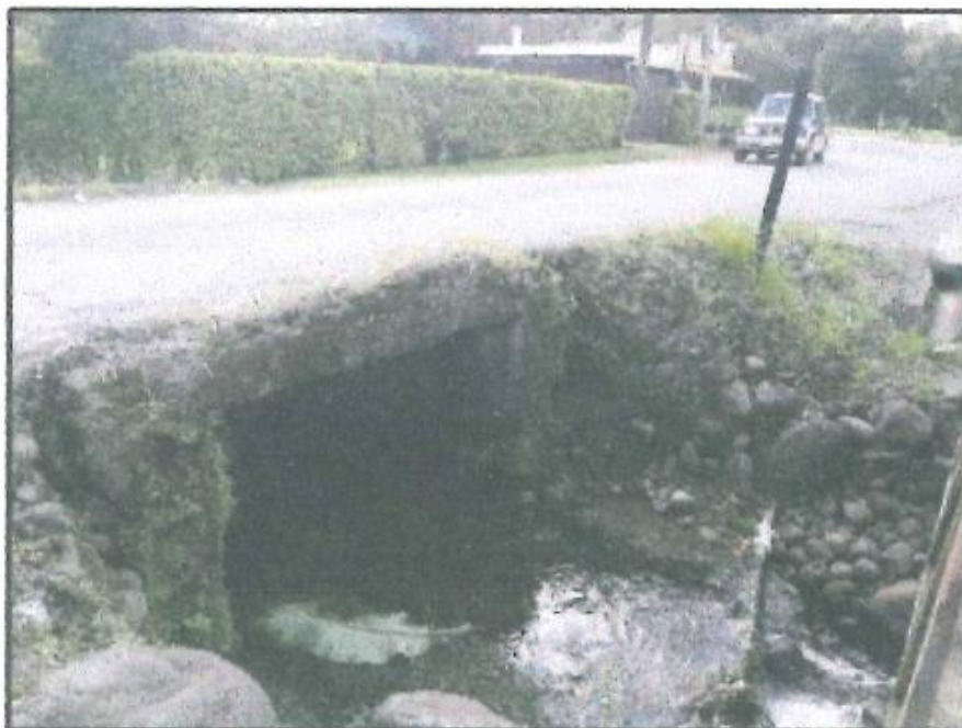
Imagen 2. Alcantarilla camino Pococí 7-02-080
