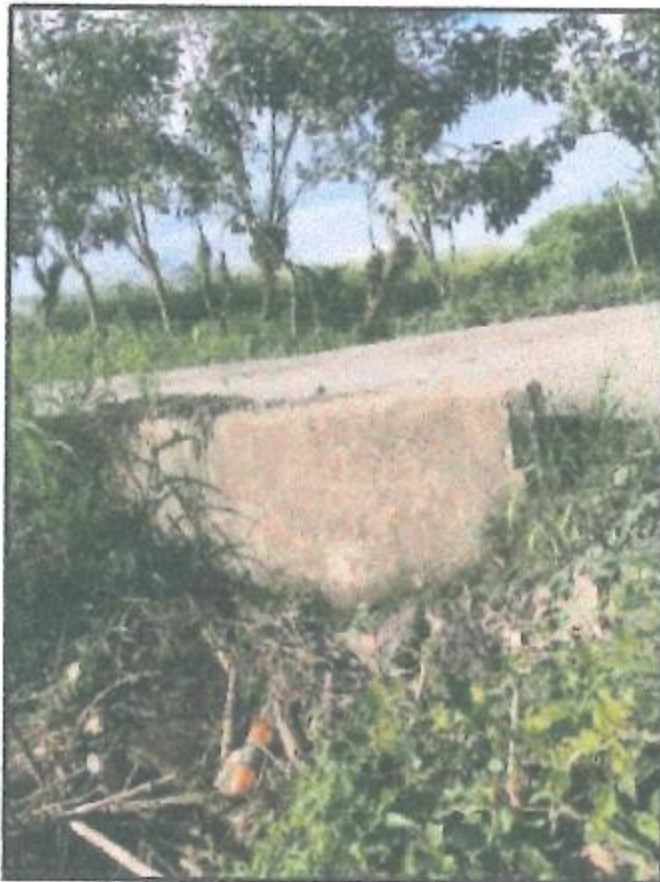
Imagen 4. Alcantarilla camino Pococí 7-02-086
